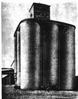
Silo à grain.
